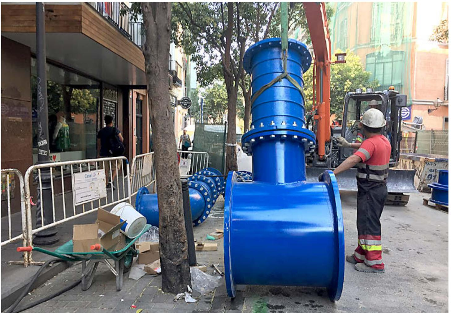
Las canalizaciones obsoletas se están reemplazando por otras fabricadas con materiales más avanzados.
